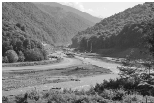
Рис. 1. Район северных порталов тоннельного комплекса № 3, июнь 2011
